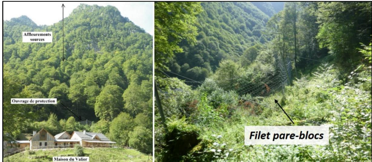
**Figure 30 : Emplacement et aperçu de l'ouvrage de protection pare-blocs dimensionné par le RTM (sources AGERINsas)**
